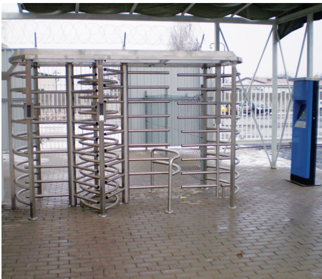
Prístupový systém – turniket
